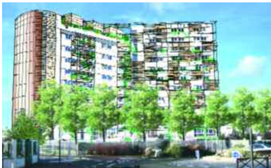
Le foyer des jeunes travailleurs va être réhabilité en résidence sociale.
